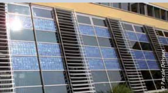
*Panneaux photovoltaïques intégrés dans le vitrage d'un bâtiment de bureaux.*
