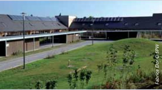
*Dans ce projet de maisons passives, les économies d'énergie sont notamment favorisées par le regroupement des logements ainsi que par des panneaux solaires thermiques pour le chauffage de l'eau sanitaire.*
